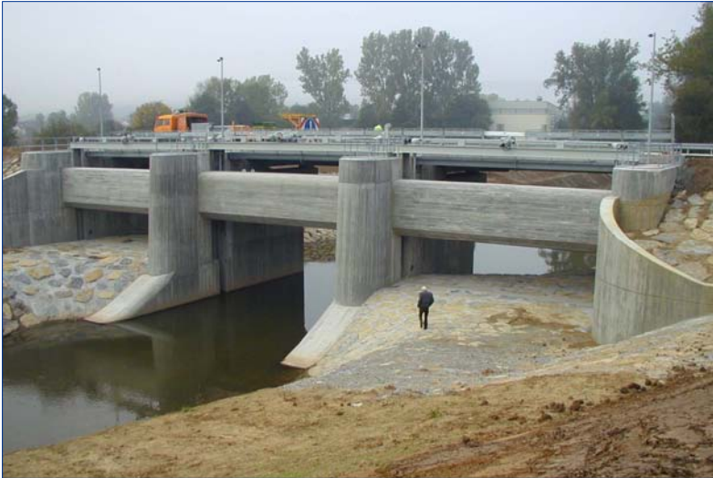
Durchlassbauwerk des Rückhaltebeckens Winterbach, Blick von oberstrom
